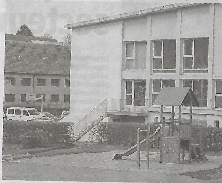
Les locaux de l'AJP, en plein centre de Plainfaing, abritent l'accueil de loisirs.
